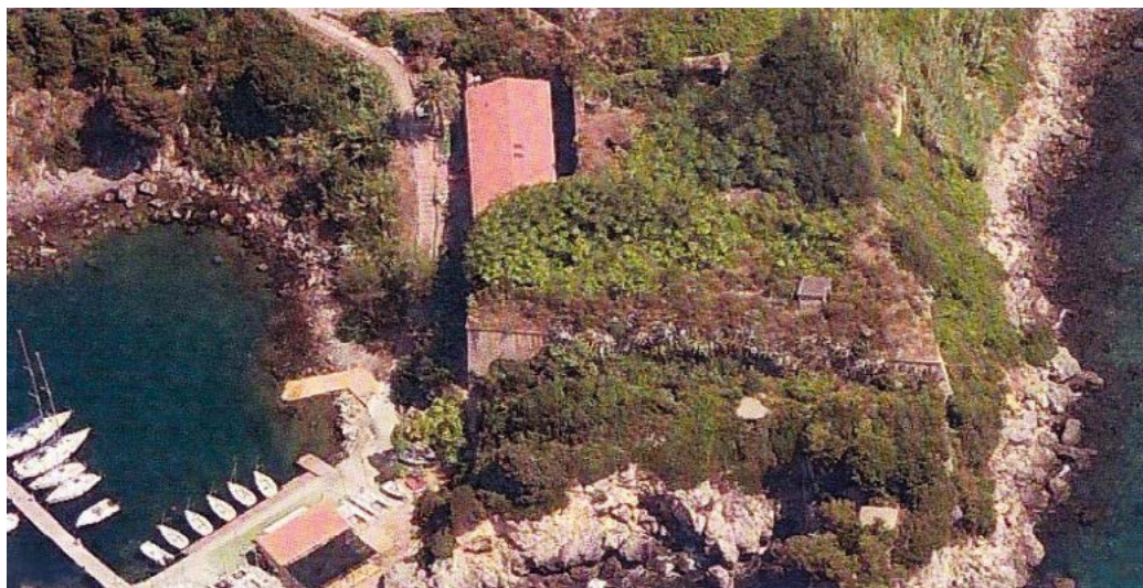
Vista in direzione Sud-Nord della Batteria: Il tracciato del fronte e dei fianchi con l'edificio della caserma
